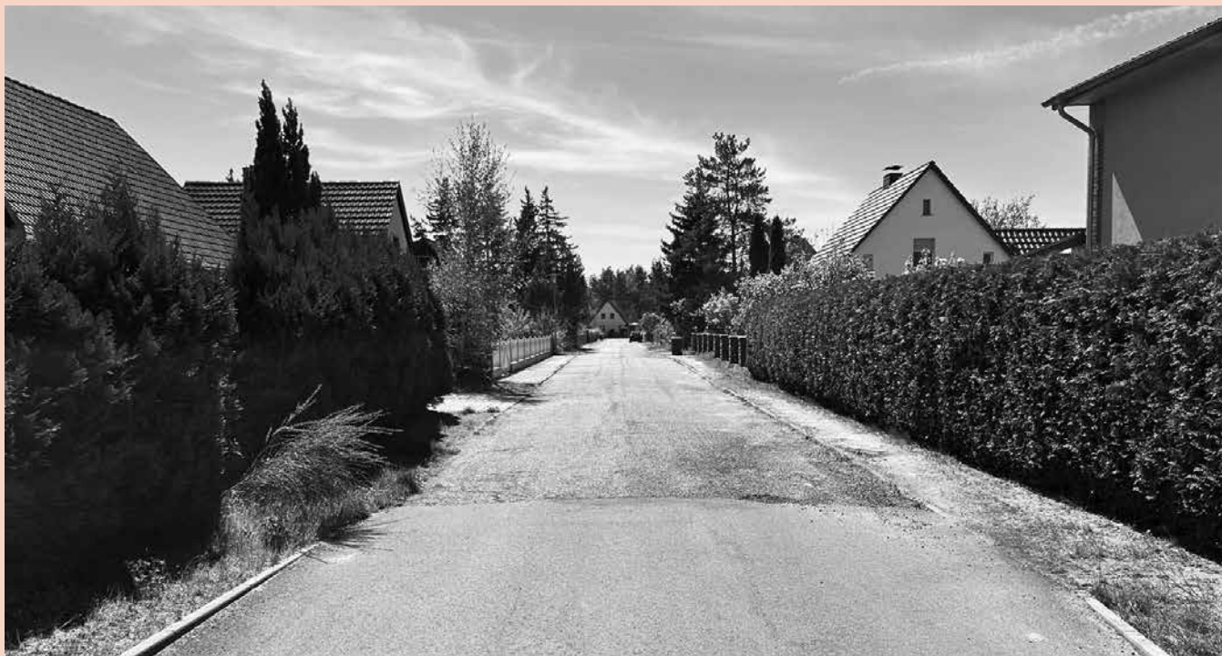
Abbildung: Karl-Liebnecht-Straße vor der Bauausführung
