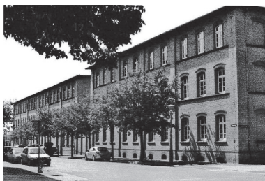
Abbildung 9: Die Alvensleben-Kaserne in Cottbus wird heute durch die Bundeswehr und das Staatstheater genutzt; Quelle: Mark Brandenburg, Heft 90, 2013
