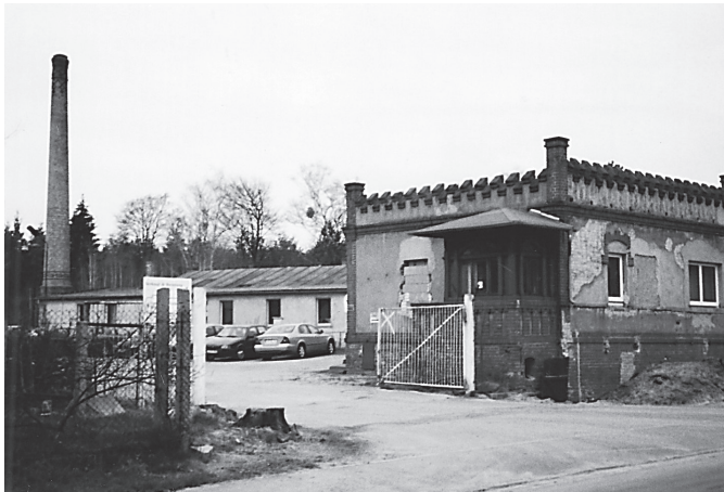
Abbildung 4: Zufahrt zum ehemaligen Betriebshof; Foto: Uwe Kulke, 2005
