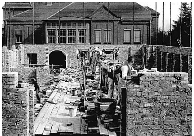
Abbildung 8: Baustelle der neuen Hauptverwaltung der Eintracht AG, 1928; Quelle: Brigitte Stelzer (+), Welzow
