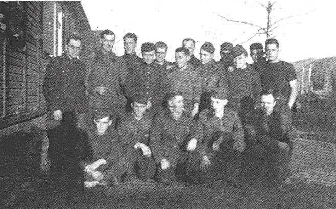
Abbildung 3: Gefangene aus der Baracke III, Bergleute aus dem Département du Nord; Quelle: Maurice Buisson
