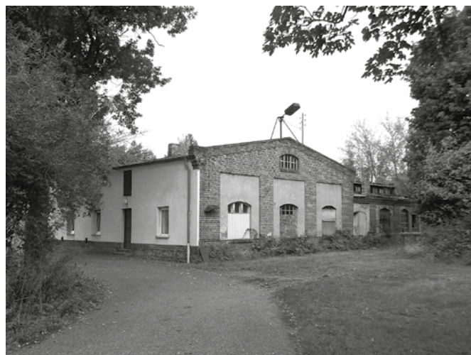
Abbildung 3: ehemalige Werkstatt und Einbindestube der Bismarckhütte, ab 1935 Gemeindewerke, mit der 1913 geschaffenen neuen Zufahrt; Foto: Uwe Kulke, 2020
