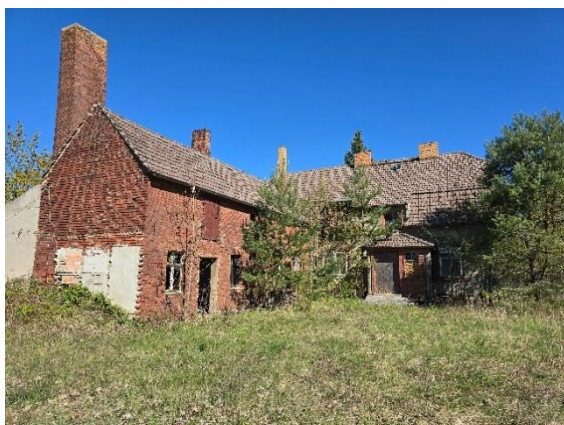
Wohnhaus mit Anbau Südseite
