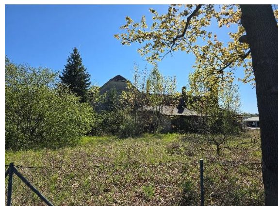
Wohnhaus mit Anbau Werkstatt Westseite
